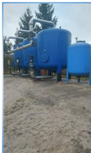
Modernizacja Stacji Uzdatniania Wody w Żelowie
