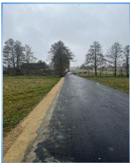
Remont drogi gminnej Pożdżenice - Sobki
