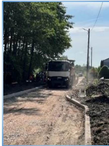
Prace nad nową nawierzchnią drogi na ul. Łąkowej w Zelowie
