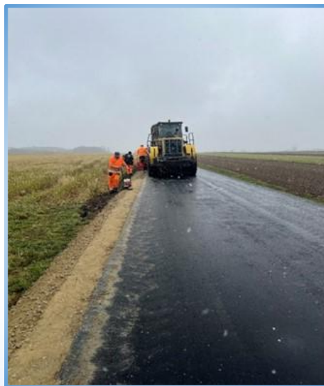
Remont drogi gminnej Pożdżenice - Sobki
