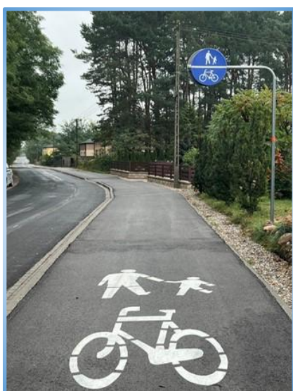
Wykonanie nawierzchni chodnika w Ignacowie
