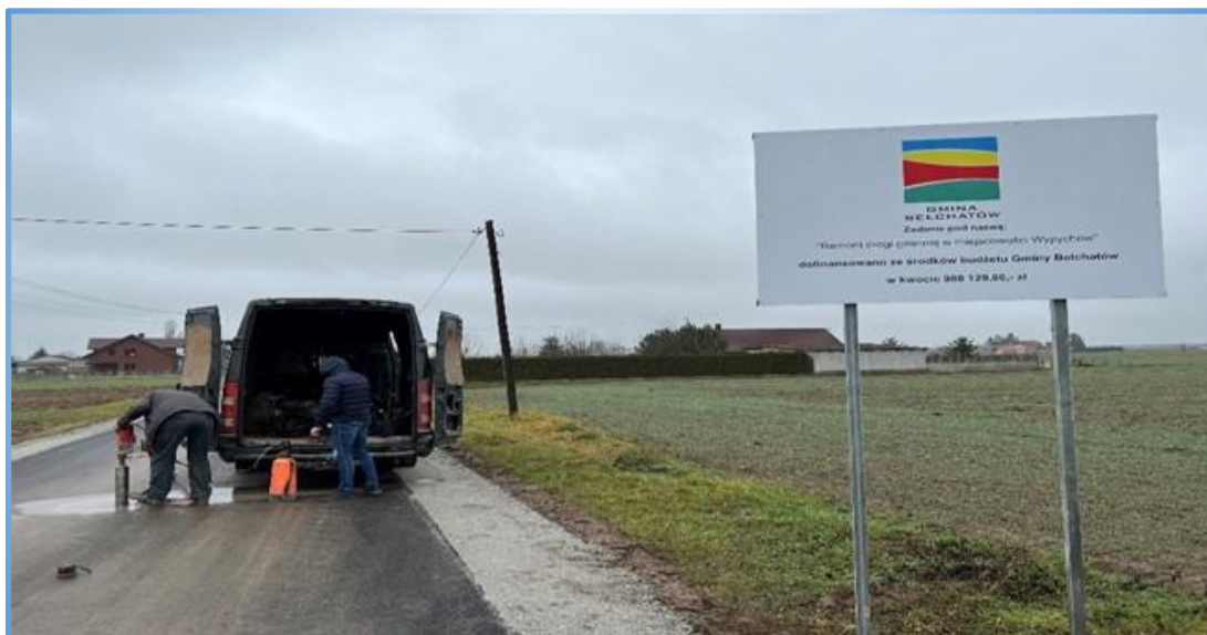
Remont drogi gminnej w miejscowości Wypychów
