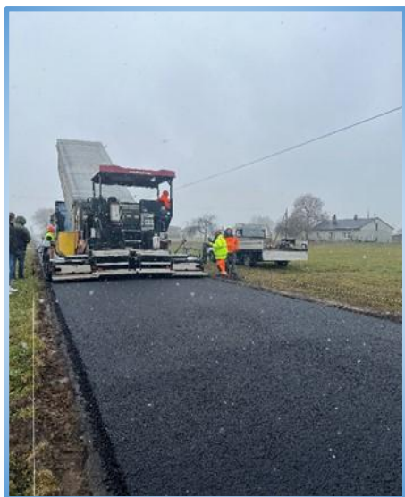
Remont drogi gminnej w miejscowości Wypychów
