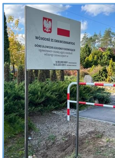
Wykonanie nawierzchni chodnika w Ignacowie
