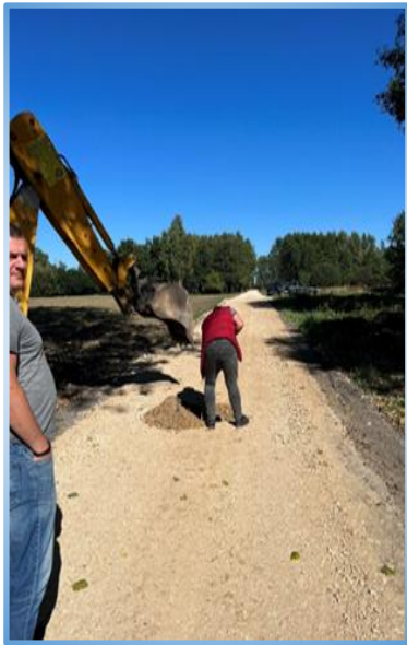
Prace nad nową nawierzchnią drogi w Kolonii Kociszew
