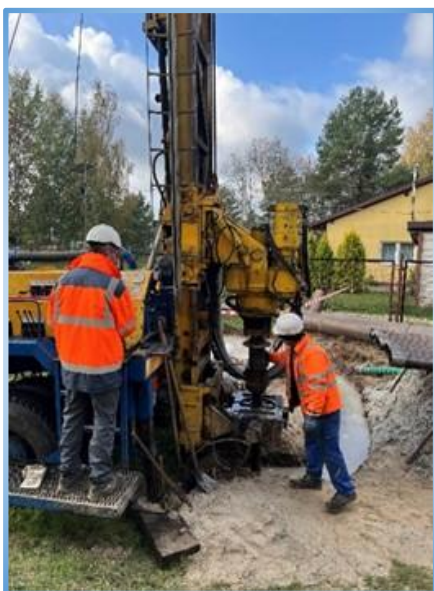
Modernizacja Stacji Uzdatniania Wody w Żelowie
