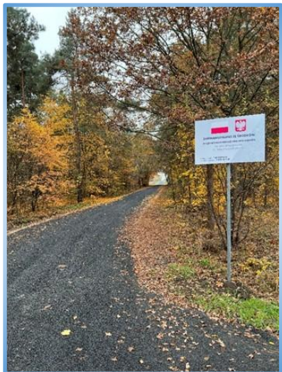
Remont drogi gminnej w miejscowości
